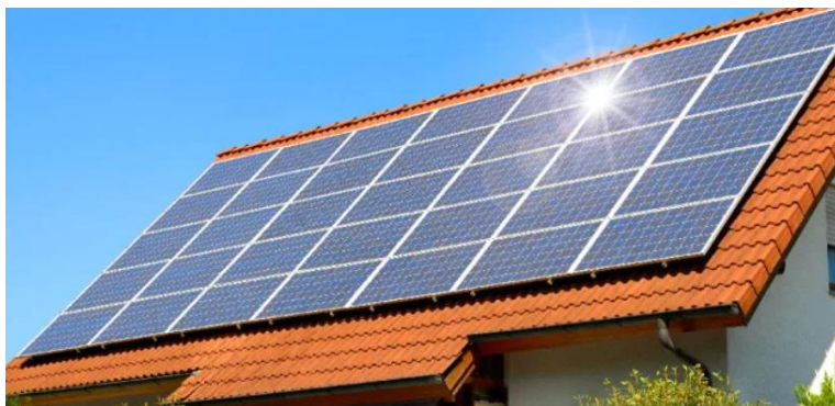
Figure 7: Photo de panneaux solaires sur un toit [14]
