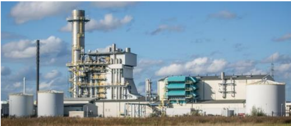
Figure 6: Photo de la centrale à gaz de Tessenderlo [10]
